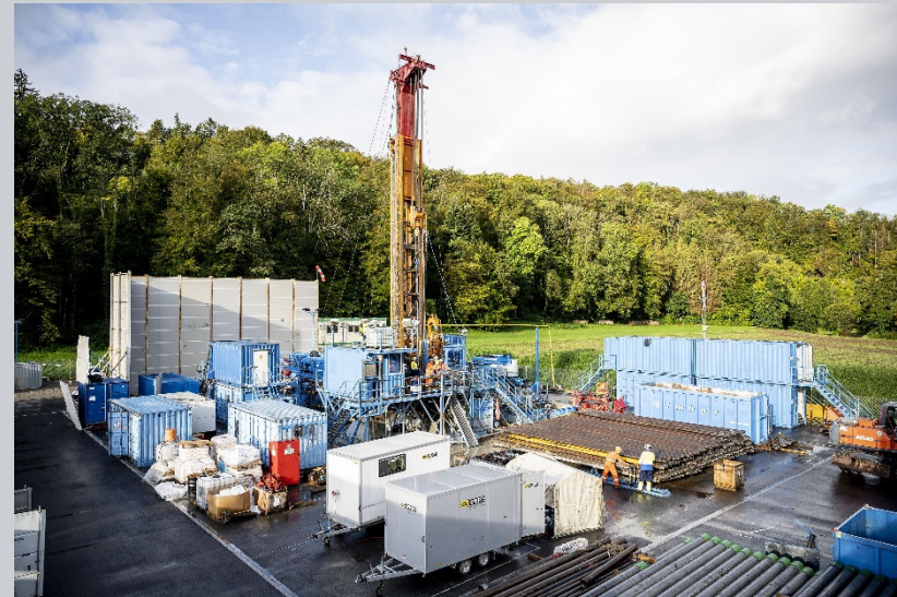
Geologische Erkundung Tiefbohrung Bühlach 2019 © Nagra
